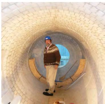
Обшивка наших камер сгорания оптимально подходит к данному процессу, т.е. мы поставляем как обшивки из керамиковолоконных матрасов, так и обшивки из огнеупорного бетона и кладочного камня.
