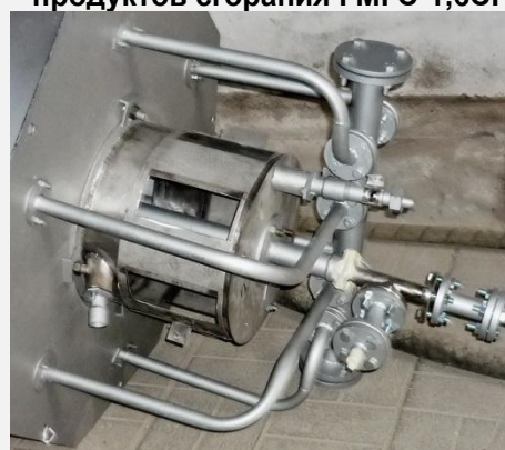
Горелка газомазутная на самотяге со ступенчатой подачей газа и рециркуляцией продуктов сгорания ГМГС-1,6СР
