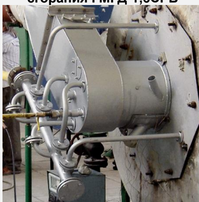
Горелка газомазутная дутьевая со ступенчатой подачей газа и рециркуляцией продуктов сгорания ГМГД-1,6СРВ
